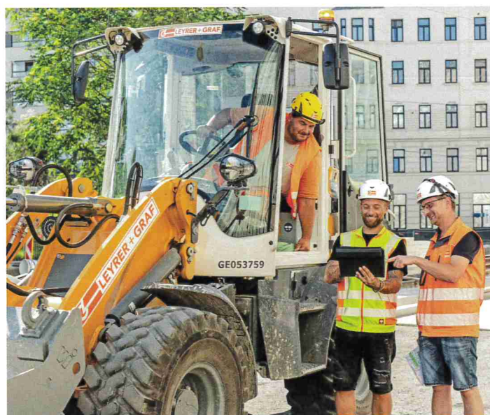
Teamwork und Technik auf der Baustelle (von links): Bahnbauer Zdenko Stopa, Gleismeister Christoph Genser und Bauleiter DI Mathias Schwarzhinger BSc).
