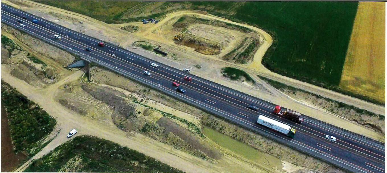
Die A 4, die Ostautobahn, erhält eine dritte Spur. Neue Ab- und Auffahrtsrampen werden gebaut, Brücken errichtet, bestehende saniert.
