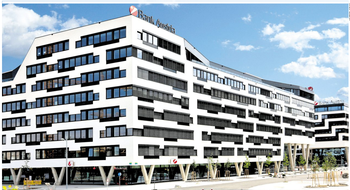
Der Austria Campus ist ein Prestigeprojekt des niederösterreichischen Bauunternehmens Leyrer + Graf
