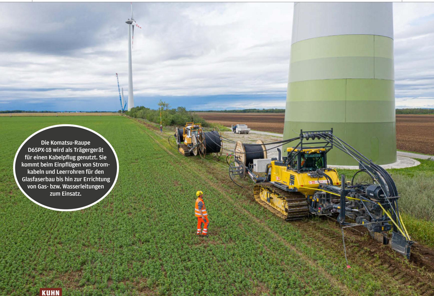
Die Komatsu-Raupe D65PX-18 wird als Trägergerät für einen Kabelpflug genutzt. Sie kommt beim Einpflügen von Stromkabeln und Leerrohren für den Glasfaserbau bis hin zur Errichtung von Gas- bzw. Wasserleitungen zum Einsatz.
