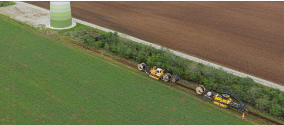
Der neue Kabelpflug schafft Rohrdurchmesser bis DA200 (200 mm) sowie Verlegetiefen bis zu 2,10 m.
