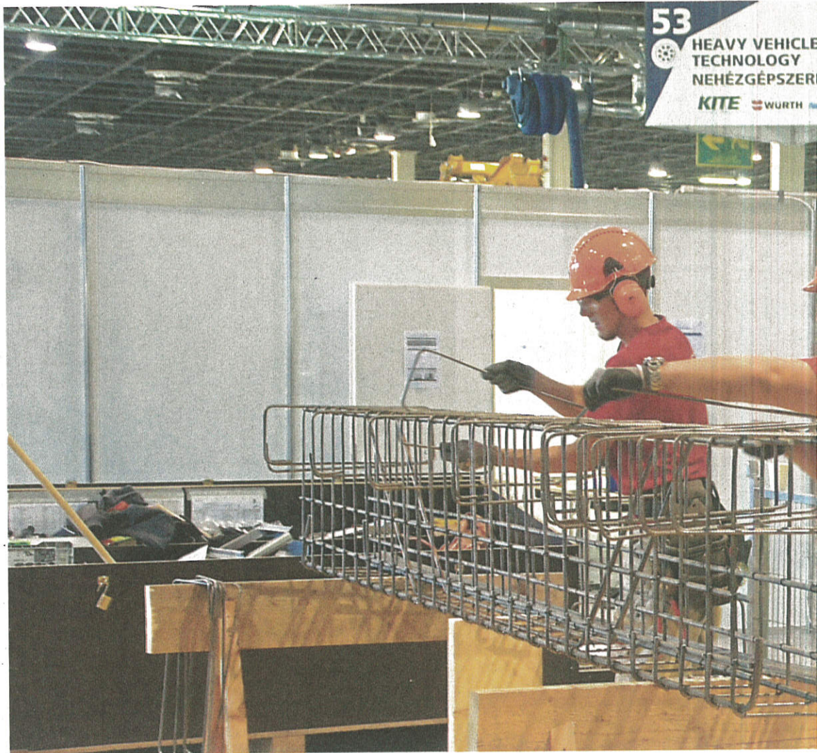
Die Betonbauer Sebastian Frantes und Markus Haslinger bei der Arbeit.
