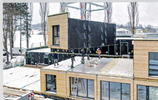
Der Hotelanbau besteht aus 16 Modulen mit den Außenmaßen 8,50 m x 3,50 m x 3,00 m und 14 Modulen mit den Außenmaßen 7,50 m x 3,50 m x 3,00 m.
