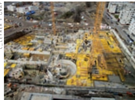
Mittlerweile macht die größte niederösterreichische Baufirma über 200 Millionen Umsatz pro Jahr und kratzt 2016 an der 2.000-Mitarbeiter-Marke, Tendenz bei beidem steigend.
