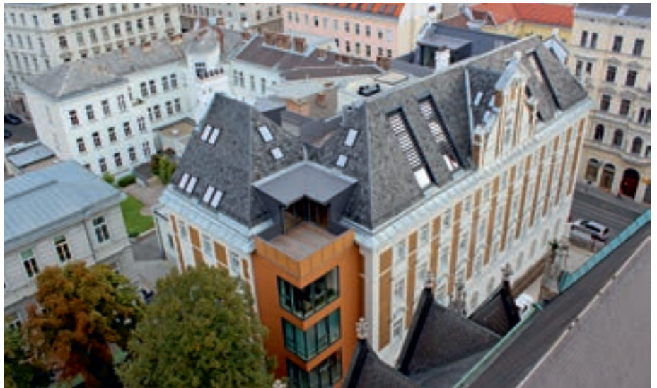
Leyrer+Graf sind gern gesehene Partner bei qualitativ hochwertigen Projekten - hier der Umbau Wien Kaiserstraße 7 mit akp Architekten.
